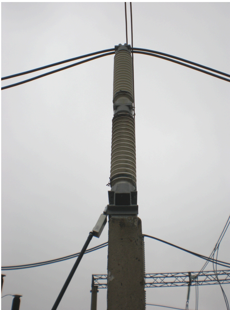
Рисунок 12 – Образец шлейфового изолятора на внешней опоре, колонка 220 кВ
