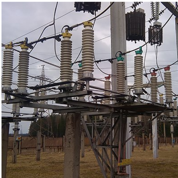
Рисунок 8 – Образец разъединителя 110 кВ с одним опорным изолятором на раме
