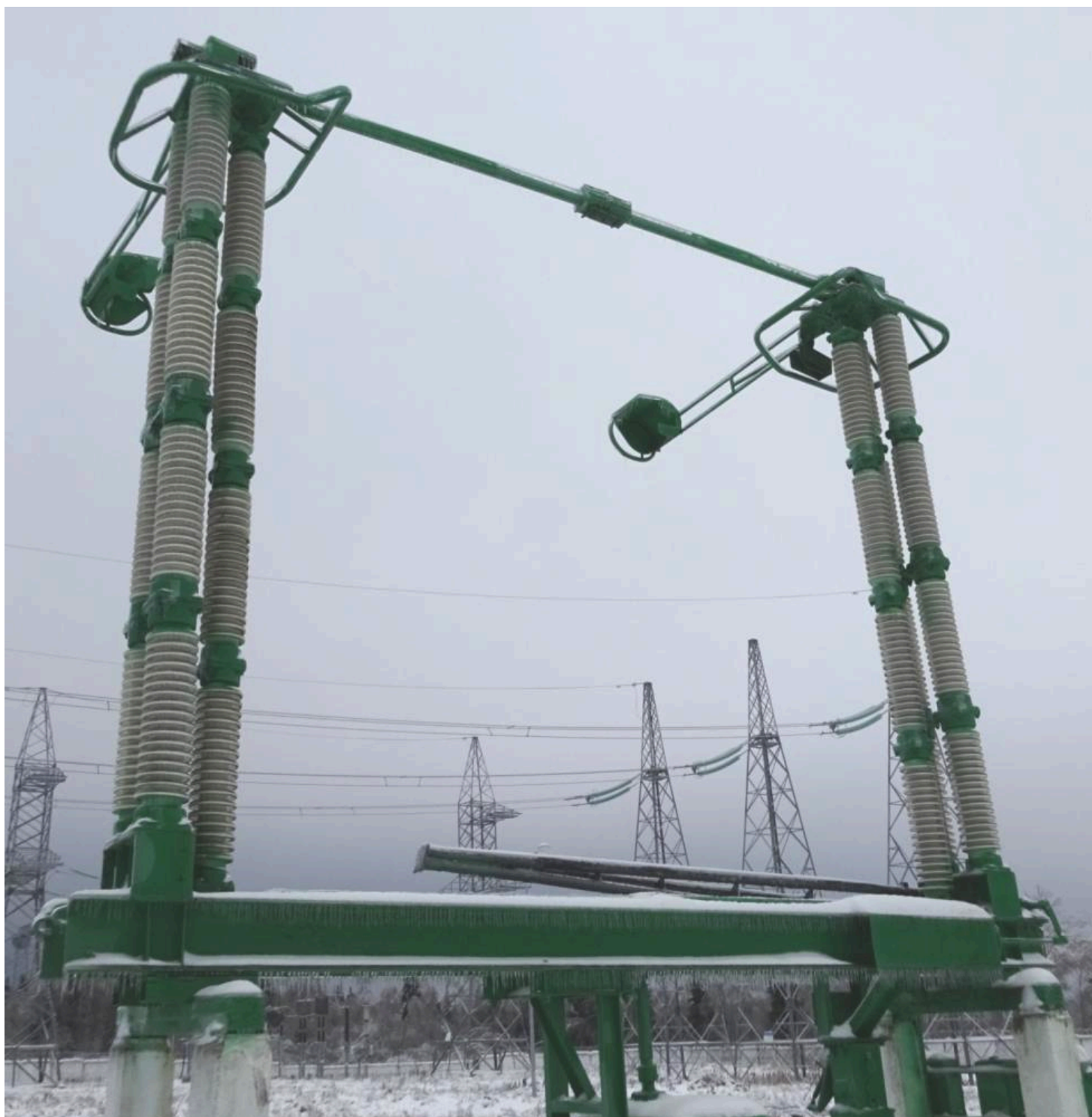
Рисунок 10 – Образец разъединителя 500 кВ с двумя опорными изоляторами на раме
